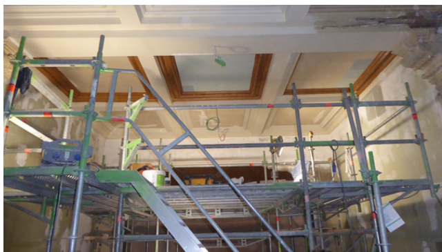
Werkzaamheden aan het plafond in de traphal en op de eerste verdieping van het Huis Janssens
